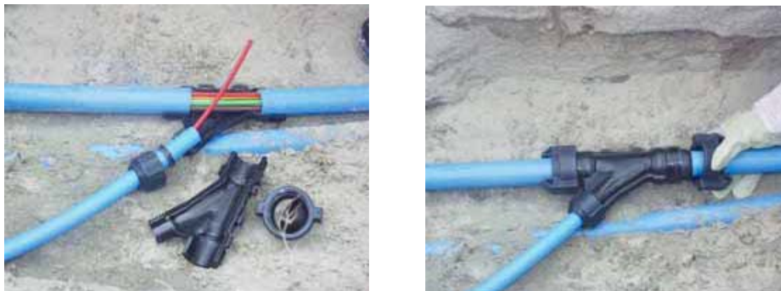
Fig. 19 Joncționarea tubulaturii
